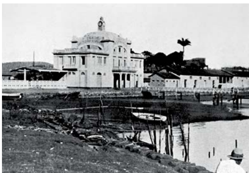
Estação Pedro Nolasco — Km 0
