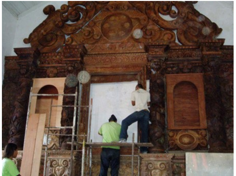
[Fig. 2] Retábulo – Recolocação dos nichos laterais novos e posicionamento da moldura do painel pictórico. Foto: Acervo NCR/UFES
